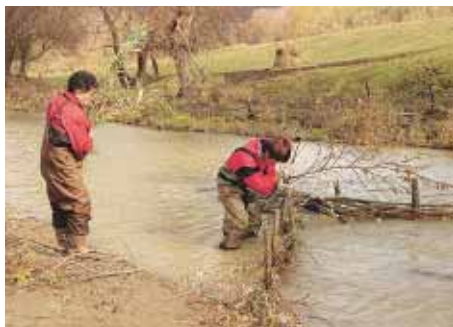
川下に入り口をむけて設置します
